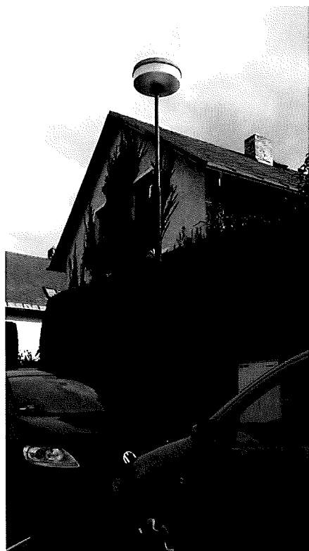
Obr. 3 Stávající sodíkové svítidlo Sadovka 70W
