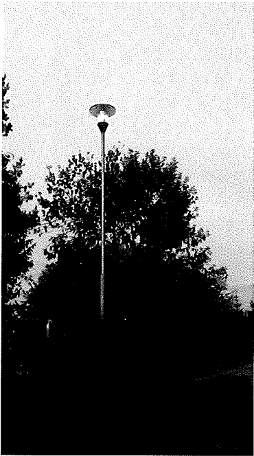
Obr. 5 Stávající sodíkové svítidlo Sadovka 70W
